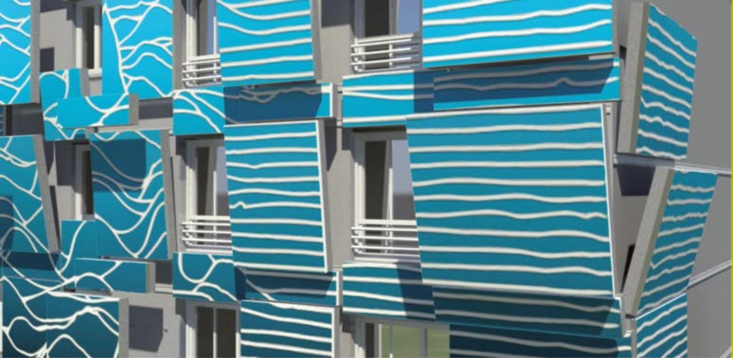
**Die WINTERFACE Fassadenlösung setzt sich aus individuellen Fassadenmodulen zusammen. Diese werden automatisiert, passgenau und montagefertig produziert.**
